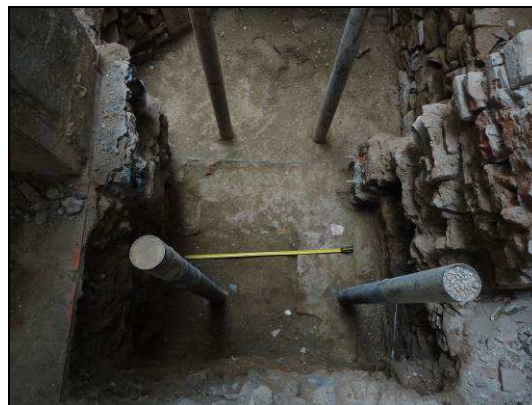
Murs UE 614 i 615 del Soterrani 2
