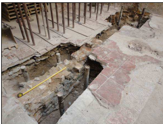
Rebaix 200 amb el mur UE 106
