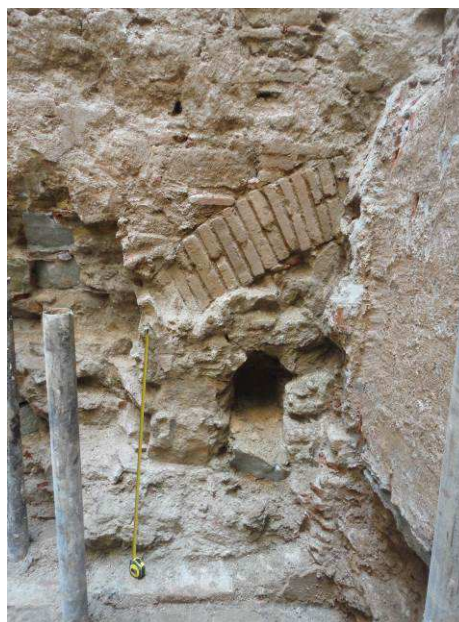
Arc UE 120 i pilar UE 121, a la fonamentació UE 118
